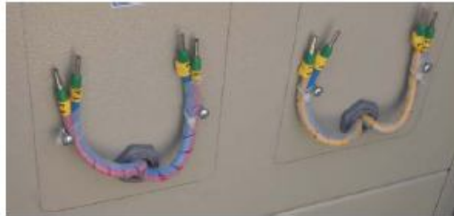
شکل(5): محل و نحوه خروج سیمها از صفحه نگهدارنده
