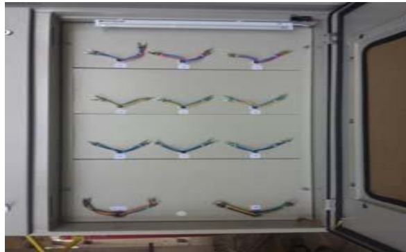
شکل (6): نمای صفحه نگهدارنده کنتورها پس از سیم کشی
